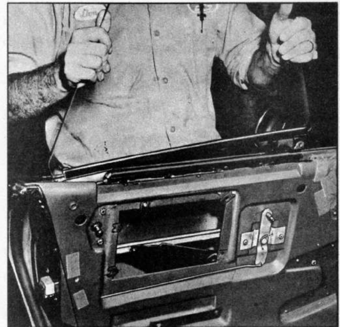
Fig. 43—Removing Door Window
